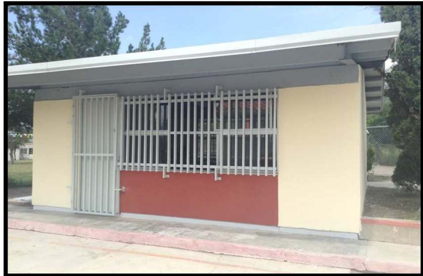
JN FEDERICO GARCIA LORCA OJO DE AGUA, SAN NICOLAS TOLENTINO, S.L.P. MEJORA DE LA INFRAESTRUCTURA FISICA EDUCATIVA DEL PLANTEL
