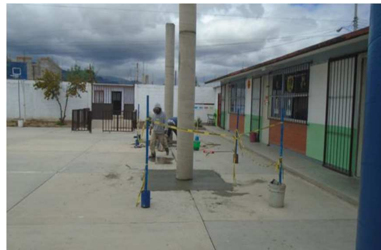
EP FRANCISCO GONZALEZ BOCANEGRA, COLONIA EMILIANO ZAPATA, DELEGACION LA PILA, SAN LUIS POTOSI, S.L.P. CONSTRUCCION DE SEGUNDA ETAPA DE TECHADO PARA PATIO CIVICO
